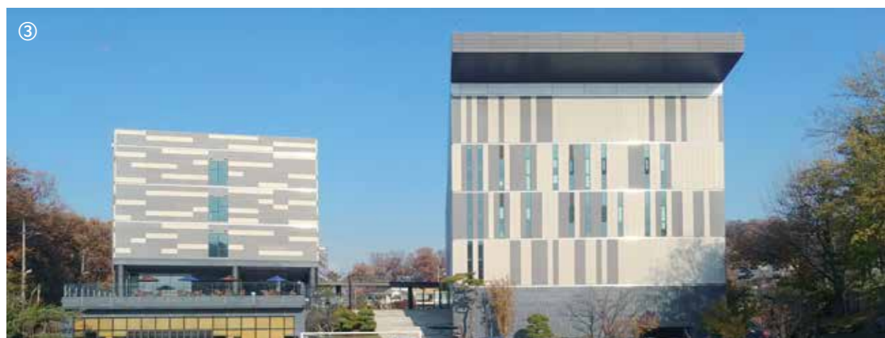
① • 공사명 : 경인아라뱃길 경인항여객터미널 • 주소 : 인천광역시 서구 정서진1로 41 ② • 공사명 : 완주보건소 • 주소 : 전라북도 완주군 삼례읍 수계리 590-6 ③ • 공사명 : YBM연수원 • 주소 : 경기도 화성시 정남면 세자로 317
