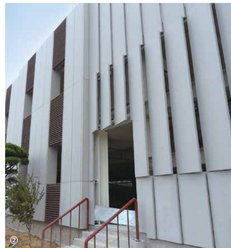
① •공사명 : 월남동성당 •주소 : 경상남도 창원시 마산합포구 3.15대로 79 ② •공사명 : 창원 LG전자 주차장 •주소 : 경상남도 창원시 성산구 성산패총로 170
